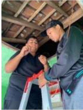
Gambar 7. Pemasangan Instalasi Listrik
