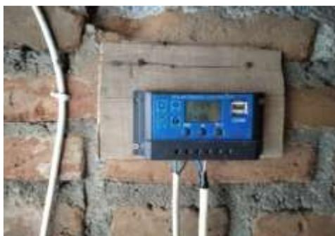
Pada Solar charger controler yaitu digunakan untuk mengontrol proses pengisian muatan energi listrik dari panel surya diproses ke solar charger controler dan disimpan energi ke aki, solar cahrger controler akan melakukan pengisian muatan energi listrik ke aki dengan arus besar ketika aki kosong, dan kemudian arus pengisian diturunkan secara betahap ketika aki semakin penuh.
