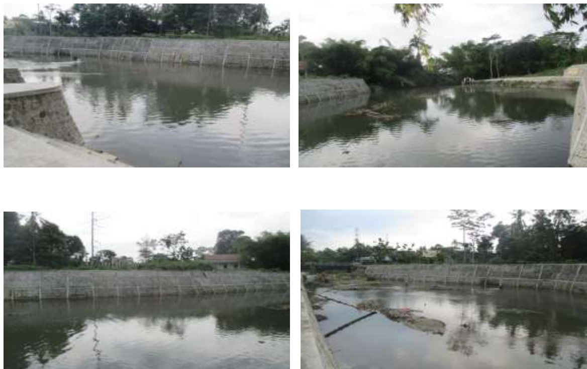
Gambar 2 : Kondisi Eksisting DAM Tanggung di Kelurahan Tanggung – KotaBlitar
