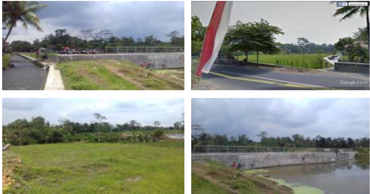
Gambar 1 : Kondisi Eksisting Embung Jatimalang di Kelurahan Sentul di KotaBlitar
