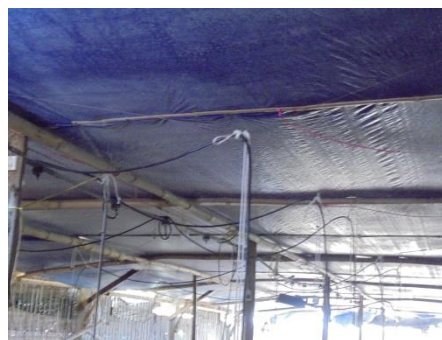
Gambar 2. Plafon dibuat di bawah atap kandang
