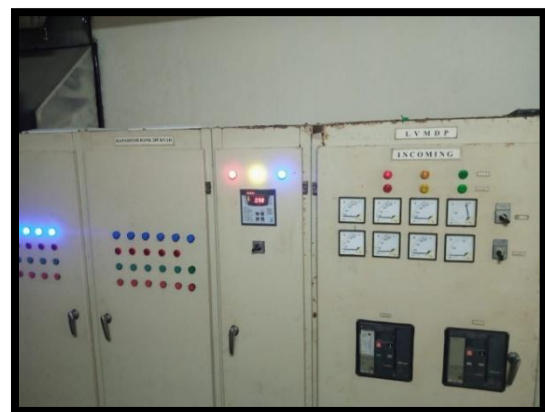
Gambar 4. LVMDP dan Kapasitor Bank Control
