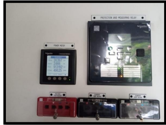
Gambar 3. Monitoring dan Kontrol Cubicle Pelanggan
