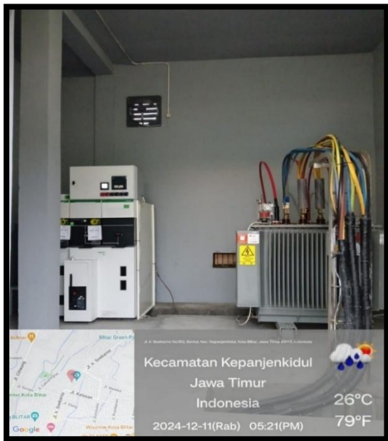
Gambar 2. Cubicle dan Transformator 630kVA
