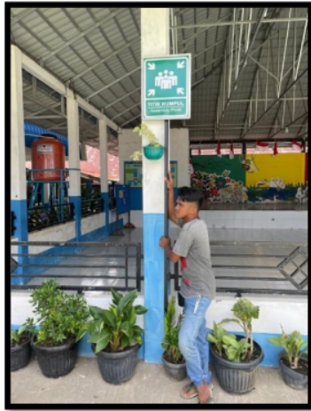
Gambar 2. Pemasangan Rambu Titik Kumpul
