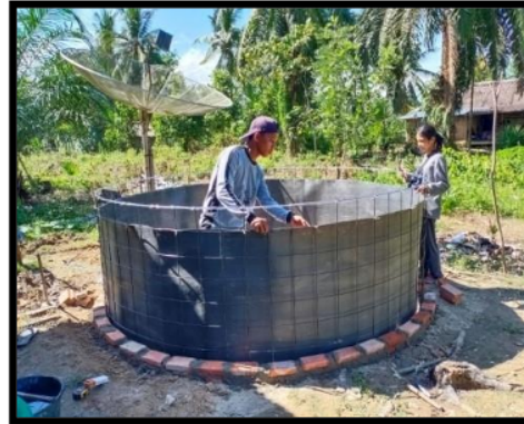
Gambar 4. Pembuatan kolam bioflok
