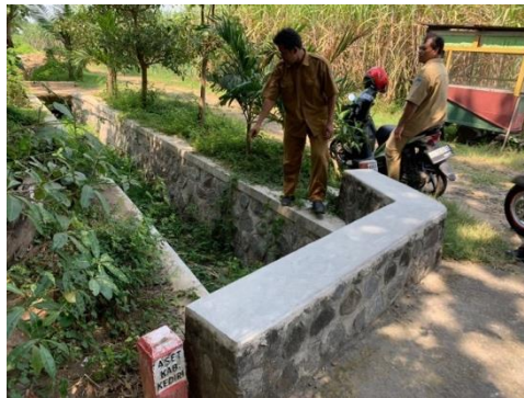
Gambar 4.3 Lokasi Pembangunan Jaringan Irigasi
